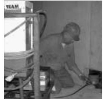
Erweiterung PS Auto-Center, Cham (Foto links) Bauherrschaft: Auto Kaiser AG, Zug. Architektur und Bauleitung: Müller + Müller, Zug. Arbeitsgattung: Pfählung / Baumeister. Besonderes: Press-Pfahl-System zur Gebäudesicherung (Foto rechts)
