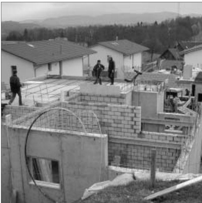
2 EFH, Sins (Foto links) Bauherrschaft: Peterhans Haustechnik AG, Sins. Architektur und Bauleitung: Beat Guggenbühl, Sins. Arbeitsgattung: Baumeister.
