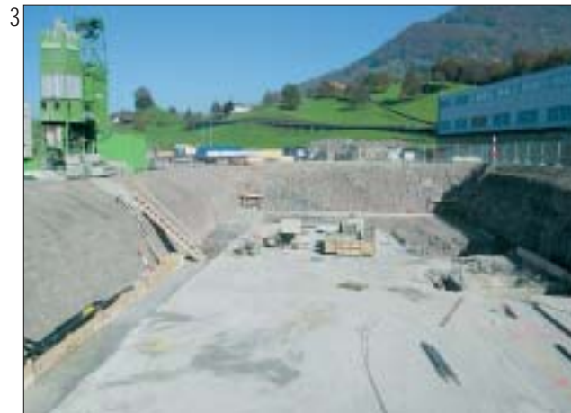
2 Wohnüberbauung "Pilatusblick", Adligenswil Bauherrschaft: Tribtschen Immobilien AG Architektur: P. Buchelli & Atelier Caviglia, Adligenswil Bauleitung: Peter Hoerner, Altdorf
